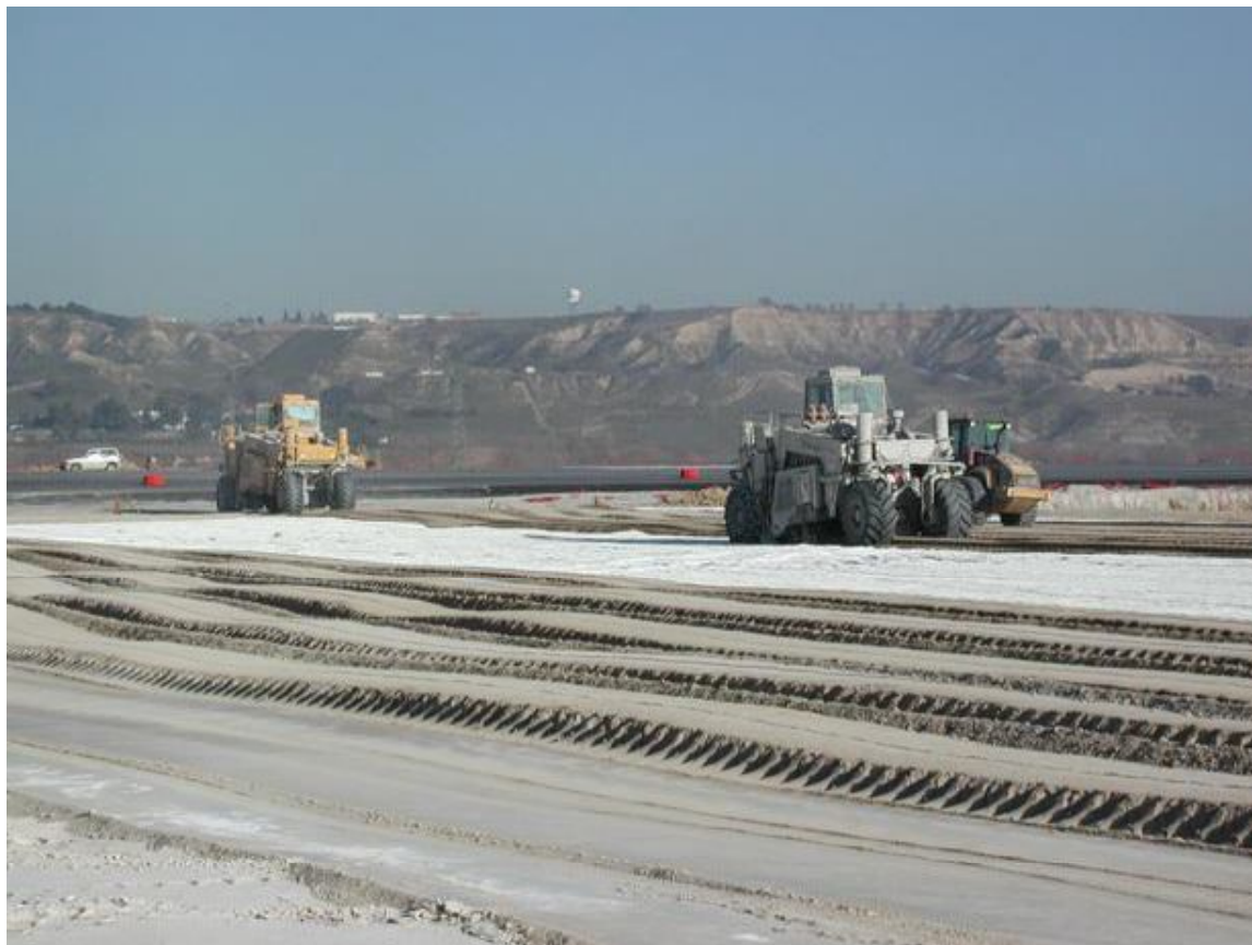
Figura 5: Tratamiento con cal en estabilización mixta.
